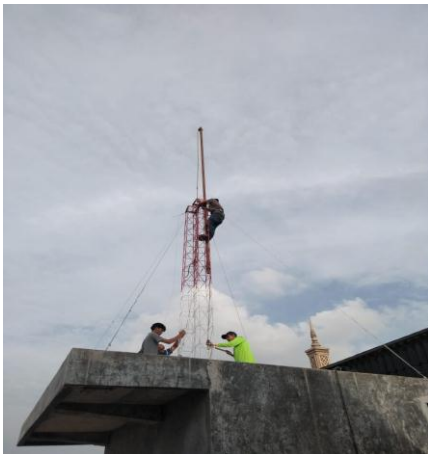
Gambar 11. Pemasangan Penangkal Petir
