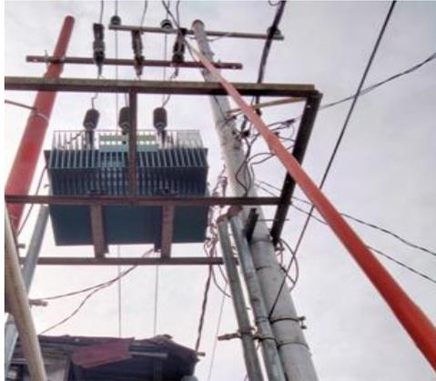
Gambar 4. 1 Pelepasan FCO Dari LBS Menggunakan Telescopic Hot Stick
