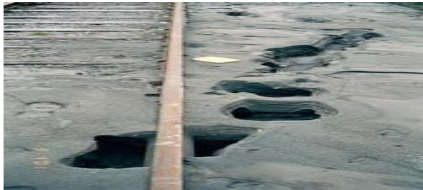
Gambar 2. Sand Boiling Akibat Likuifaksi
