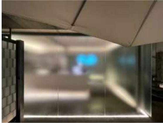
Seluruh bagian fasad bangunan café sawo menggunakan kaca bata dan kaca buram. Kaca bata dan kaca buram ini berfungsi untuk mengoptimalkan cahaya, kemudian kaca bata yang disusun zig-zag untuk menciptakan celah vertical di antara batu bata tersebut, yang memungkinkan aliran udara masuk dan keluar dari dinding batu bata kaca dan juga menghemat penggunaan material.
