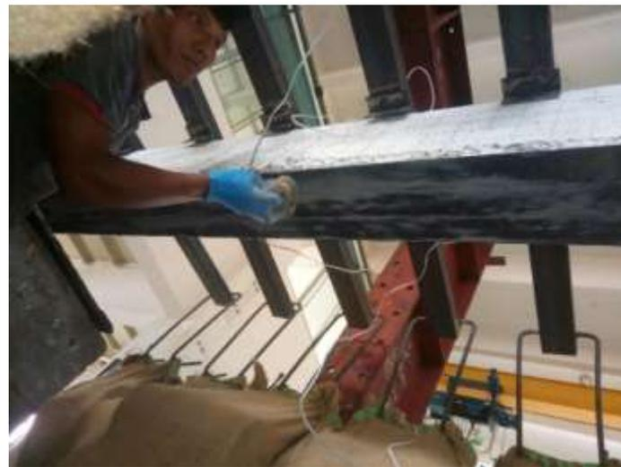
Gambar 3. Pemasangan CFRP Strips
