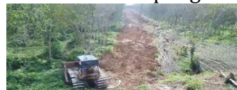
Gambar:1. pembersihan lapangan/lokasi
