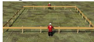
Gambar 2. pemasangan bowplank dan pengukuran
