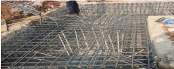
Gambar 6. Penulangan pile cap
