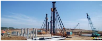
Gambar 5. pemancangan pondasi tiang pancang
