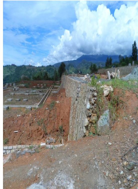
Gambar 3.2. Dinding Penahan Tanah di Lokasi Skyland Jayapura Selatan
