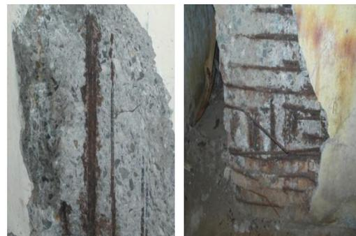
Gambar 1. 3. Kerusakan Pada Balok dan Kolom
