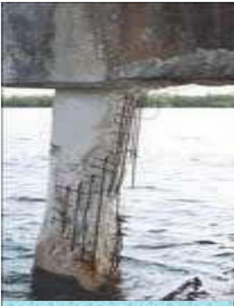
Gambar 1.1. Proses Korosi Pada Baja Tulangan
