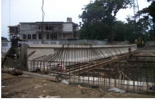
Gambar 2.3 Pencetakan Beton di lapangan
