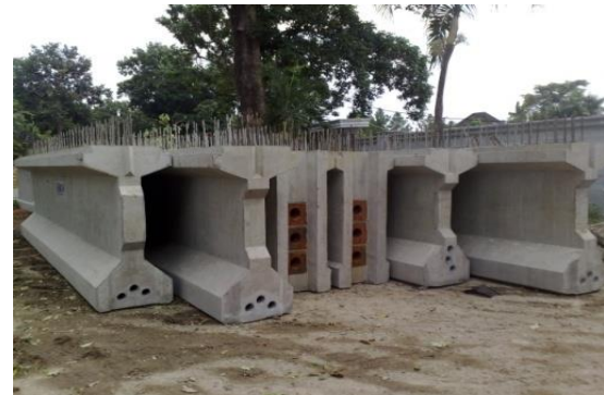
Gambar 2.7 Bentuk tampang balok girder
