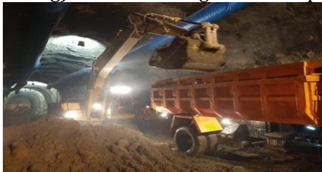
Gambar 3.8 Pengambilan material hasil ledakkan
