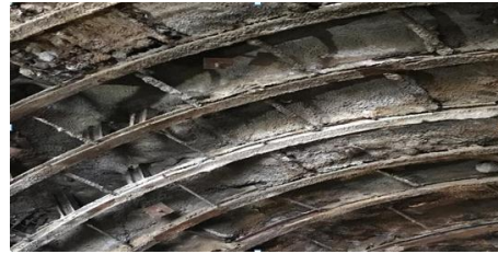
Gambar 3.12 Pemasangan steel rib
