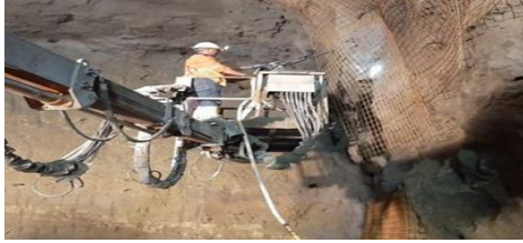
Gambar3.11 Pemasangan Wiremesh
