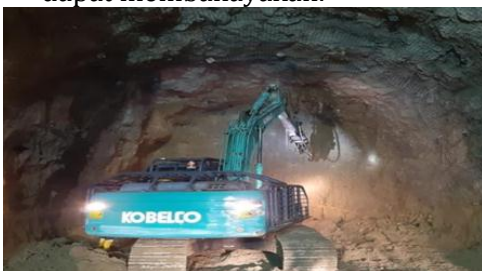
Gambar 3.9 Proses Pelaksanaan Pekerjaan Scaling
