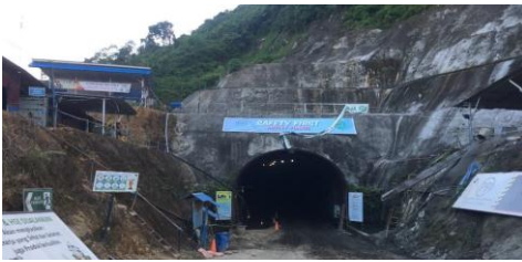
Gambar 3.2 Bangunan Pengelak Bendungan Lau Simeme, Deli serdang, Sumatera Utara.
