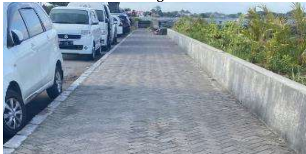
Gambar 3. Kondisi Eksisting Trotoar Pelabuhan Sanur
